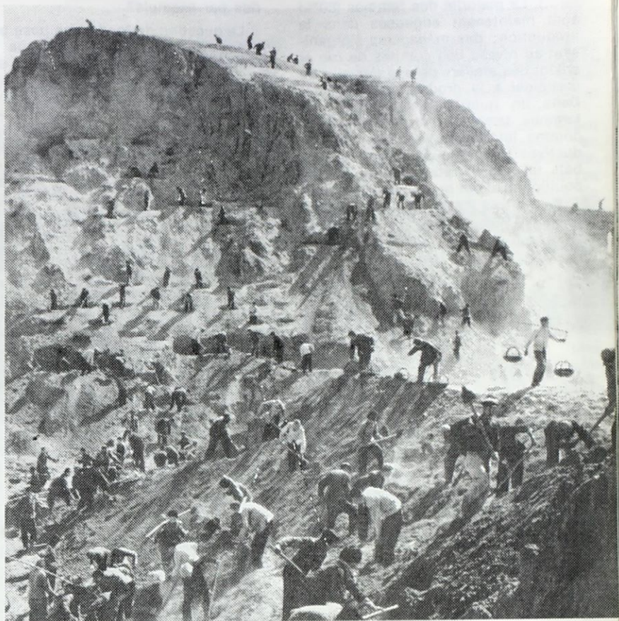
Les membres de la brigade de Viuyu en train d'aménager le versant d'une colline.
