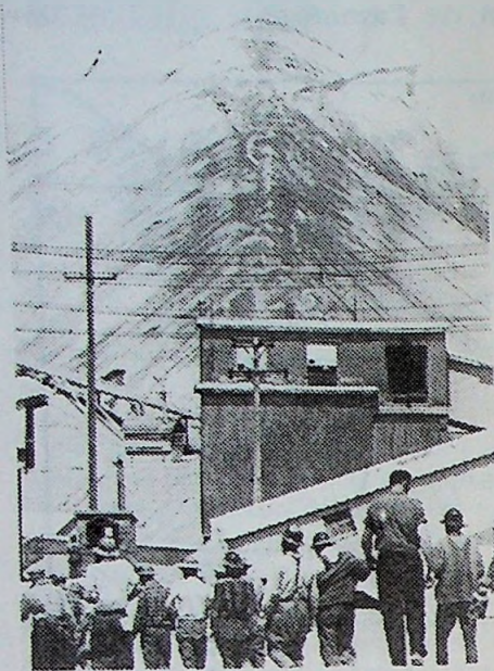
A l'entrée de la mine
